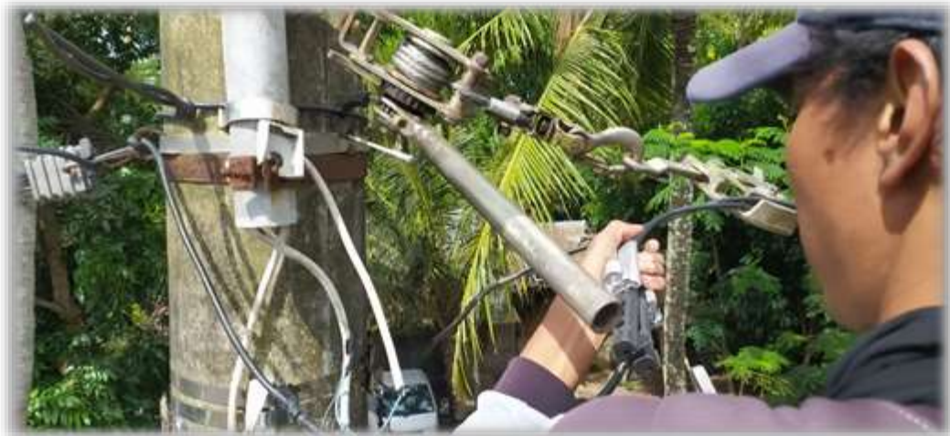
Gambar 3.1 Penanganan Kerusakan LPJU
